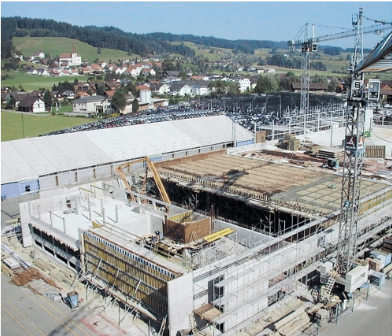
Großbaustelle unseres Kunden Anliker AG im schweizerischen Altishofen
